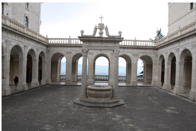
Studnia na Monte Casino na dziedzińcu klasztornym
